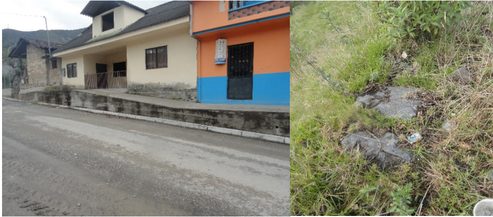
Muros de contención en el centro parroquial
