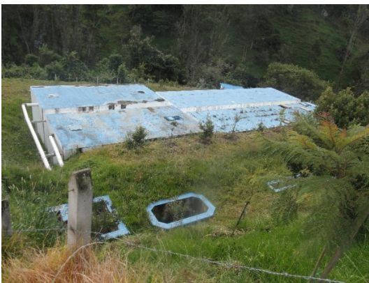
Lugar: Principal – Planta de tratamiento de agua.
