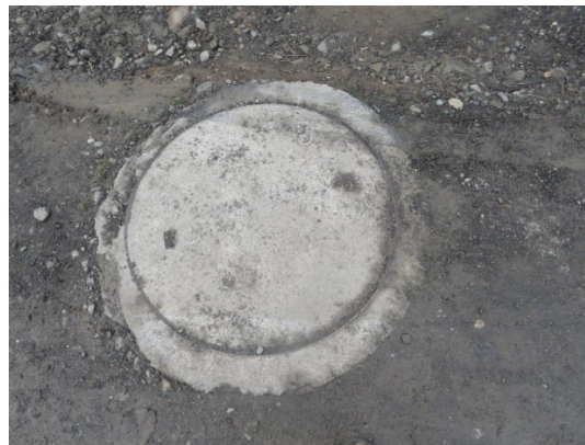
Lugar: Principal – alcantarillado.
